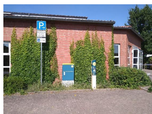
Standort Hirschbachhalle Georgenhausen
