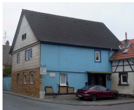
Fassadenverkleidung und Farbgebung
